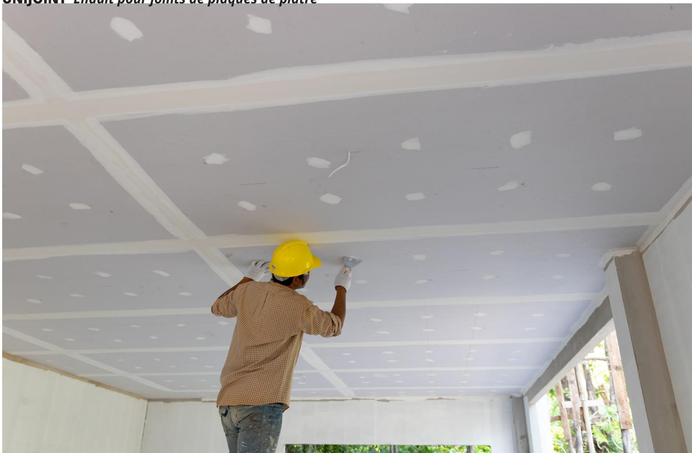
beurrant » l'aminci à l'aide d'un couteau à enduire de 10 ou 15 cm et mise en place de la bande (face meulée contre l'enduit). Effectuer ensuite une passe de finition, laisser sécher et finir pour masquer la bande.
